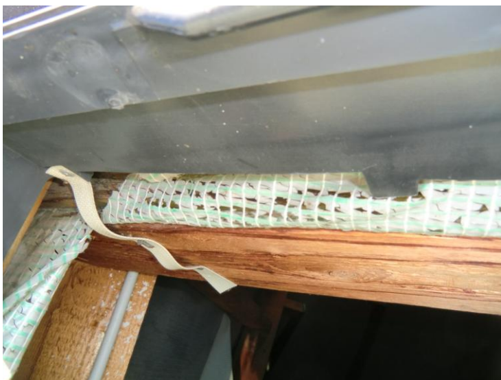
Unterspannbahn im Bereich der Dachluke
