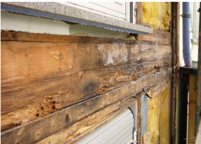
Holzkonstruktion nach dem Entfernen der Putzfassade
