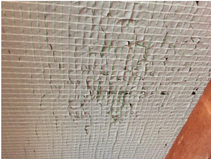
Unterspannbahn im Bereich des Spitzbodens
