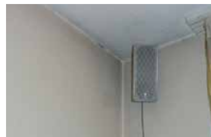
Abb. 1: Beim Fogging-Effekt bleiben die Ecken hell, weil die Luftströmung dort nicht so wirkt wie auf der »ungestörten« Fläche.
