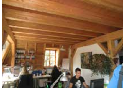
Abb. 9: Büroraum im Dachgeschoss; die für die Heizung genutzten Flächen der Außenwand sind zu klein bzw. zu sehr mit Möbeln verstellt
