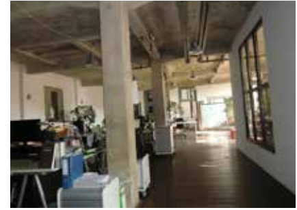
Abb. 7: Büroraum im Erdgeschoss mit Stahlbetondecke und Dielenfußboden
