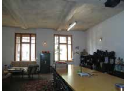
Abb. 6: Beratungsraum mit Kastenfenstern und einer sichtbar gelassenen alten Stahlbetondecke
