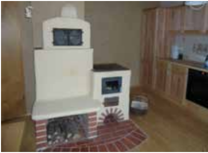
Abb. 2: Kachelofen nach dem Grundofenprinzip
