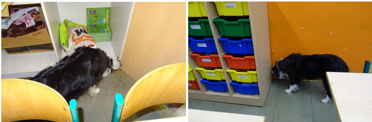
Foto 7 und 8 – Amelie verweist an der Unterkante und an der Rückseite von Schränken auf möglichen Schimmel
