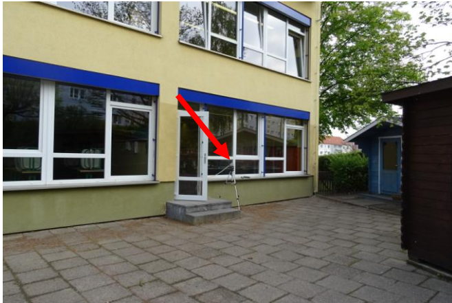
Foto 6 – Ansicht vor dem Schulraum mit dem Luftkeimsammler ( roter Pfeil )
