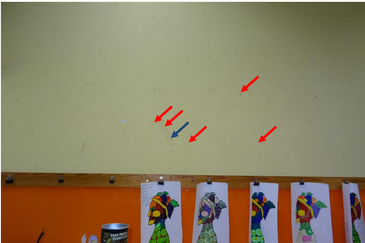
Foto 5 – Zahlreiche, kaum sichtbare Flecken an der Giebelwand ( ein paar Beispiele, rote Pfeile ); Klebefilmprobe ( blauer Pfeil )
