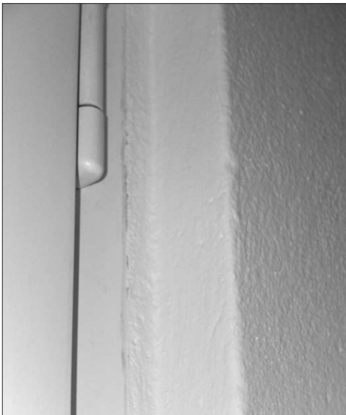
Abb. 1: Fensterleibung im Schlafzimmer mit Kalkputz und reiner Silikatfarbe – ohne Schimmel, obwohl das Fenster oft gekippt ist, nicht geheizt wird und die Türen bis einschließlich Küche häufig offen stehen
